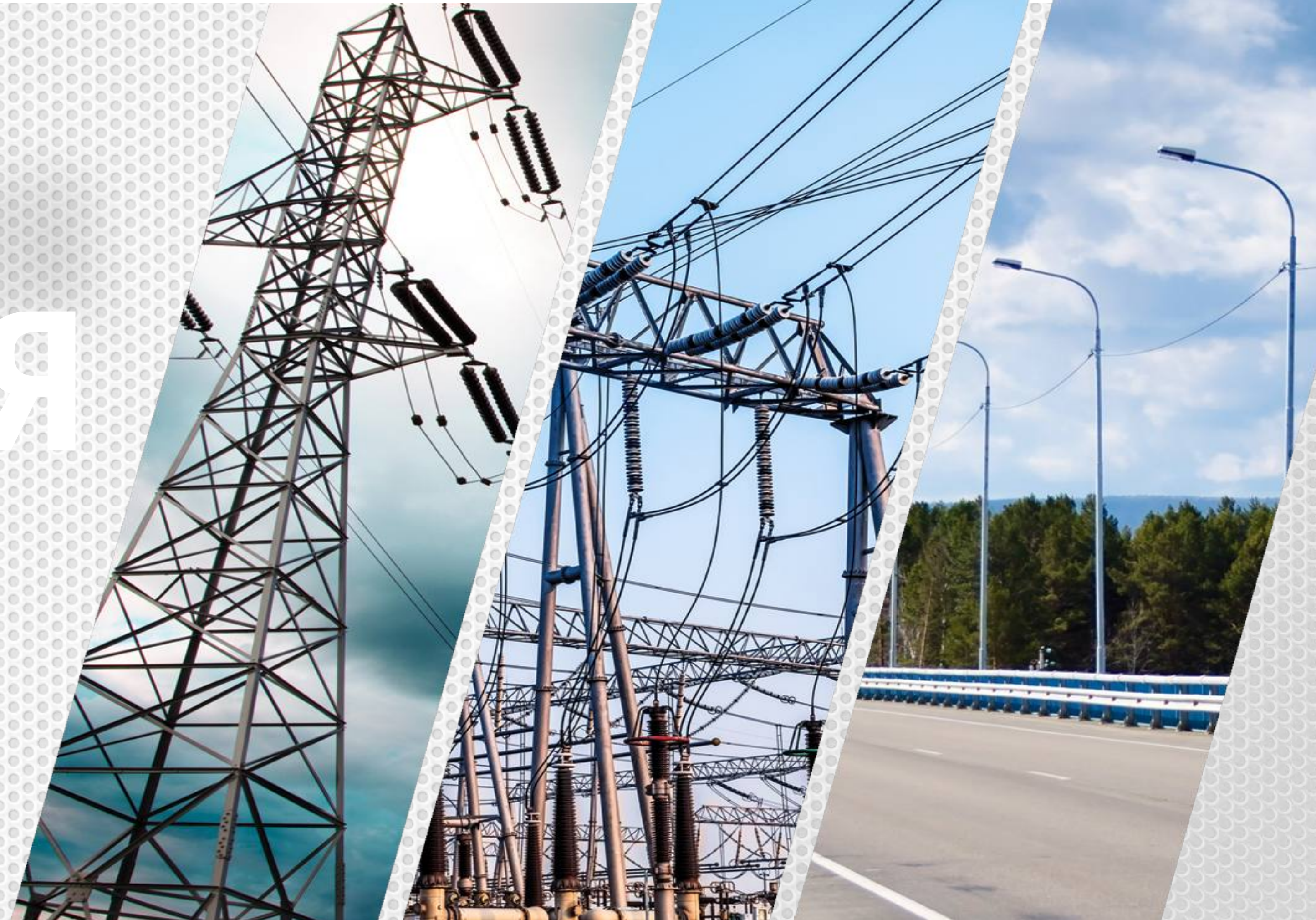
Высоковольтные линии электропередач
