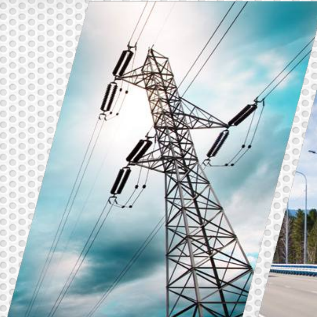
Высоковольтные линии электропередач
